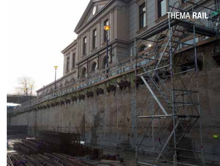
CSM-wand met aanzicht stationsgebouw.
