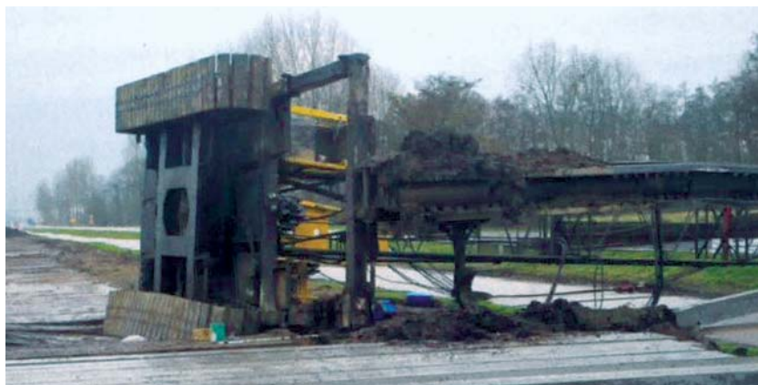
Figuur 1 – Funderingsmachine omgevallen door bezwijken van ondergrond [2].
