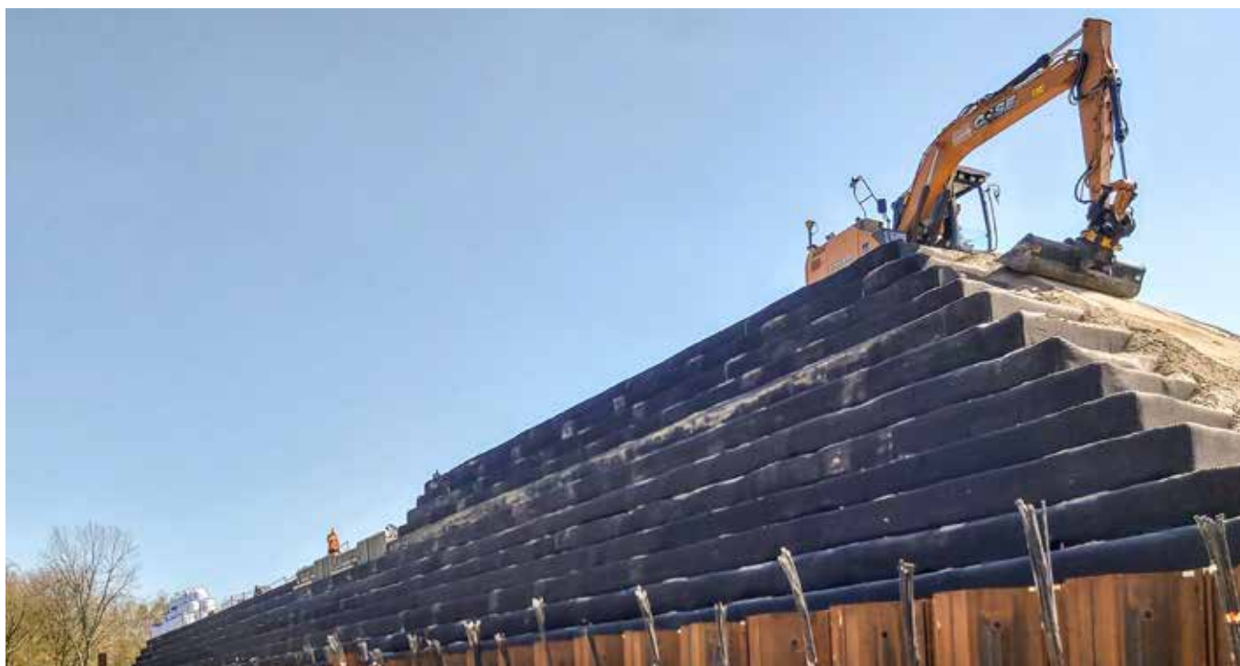
Gewapende grond en een damwand verzorgen een stabiele ophoging.
