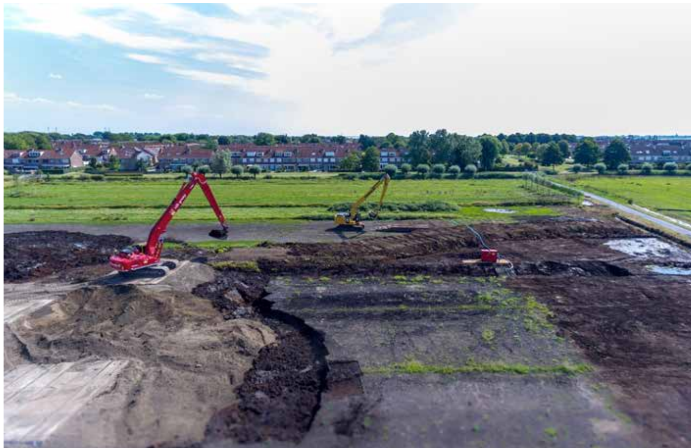
Ontgraven van de slappe ondergrond (veen).
